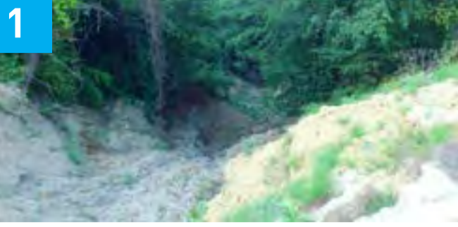
İstanbul Teknik'in GeoArme Duvar uygulamasından önce doğal arazi
