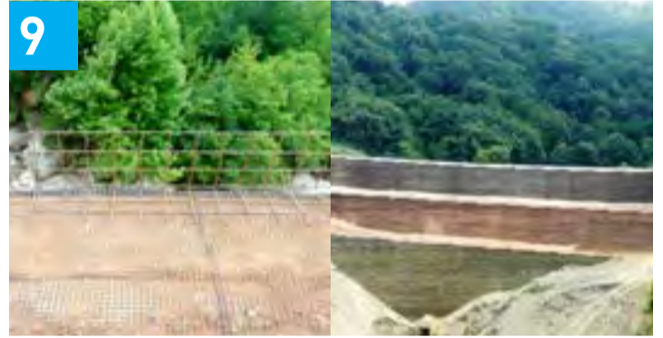
Duvar yüzey eleman detayı
