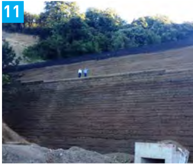
18 metre yüksekliğindeki duvar mertebesinde 2. palyeye başlanması
