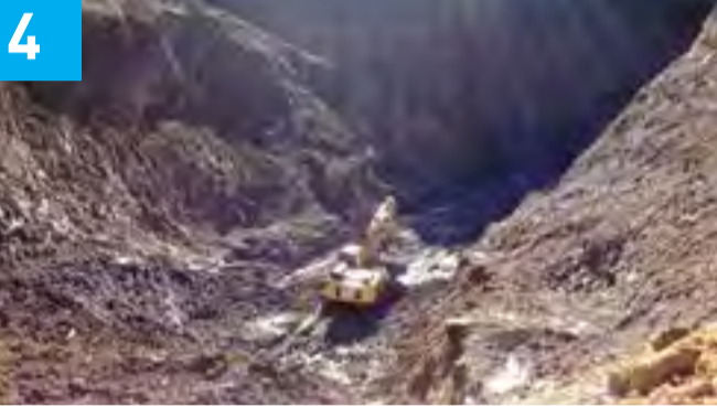
Projedeki katlara göre düzeltme ve duvar zemini hazırlama işlemi
