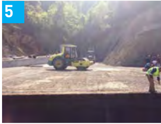
Çelik hasırda arkasında 50 - 70 cm kalınlığında nebati toprak el kompaktörü ile sıkıştırılarak serildi
