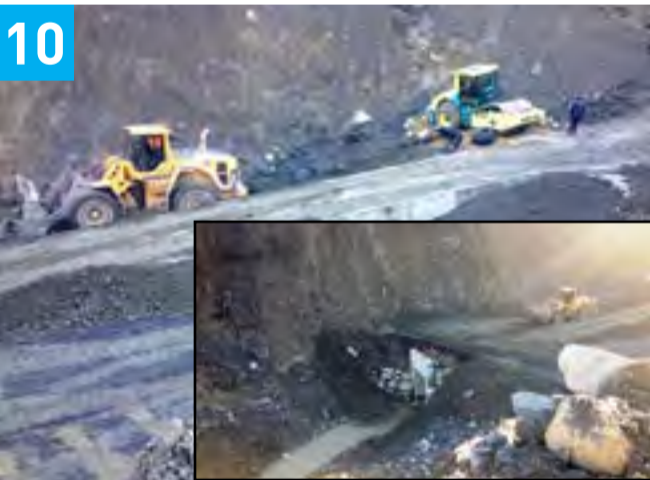
Gelen dolgu sıkıştırılarak 7. kademe atılışı
