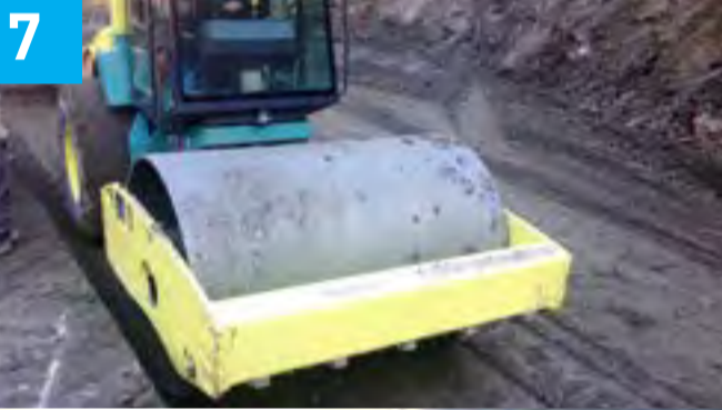
Projedeki katlara göre düzeltme ve duvar zemini hazırlama işlemi
