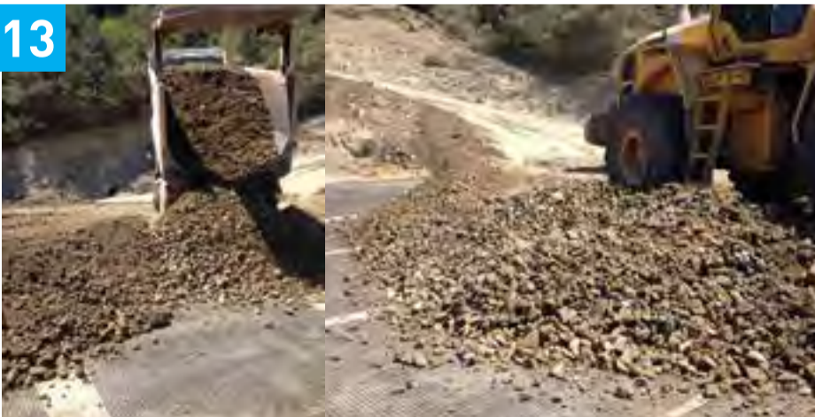
Ocaktan gelen dolgu malzemesinin geogrid üzerine dökülmesi
