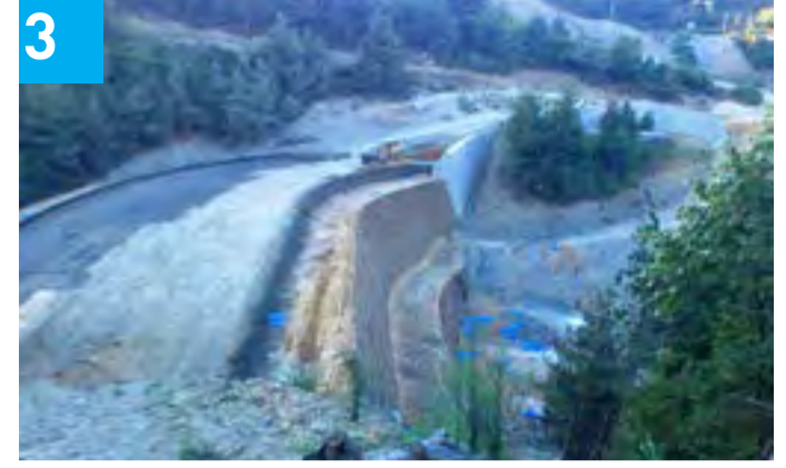
Çift yüzlü duvar imalatı devam ediyor
